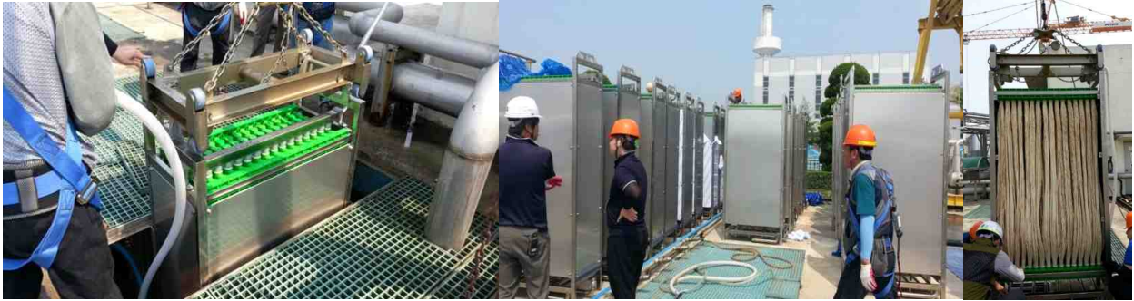
그림 8. Megaflux-MBR 설치현장 사진 (H반도체 회사).
