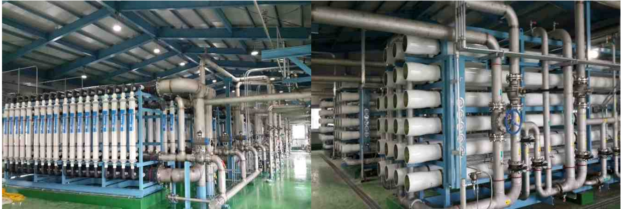
그림 5. 울산 S화학회사 물리고도폐수처리 현장설치 사진 (Super-M, NF)
